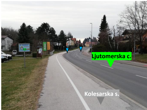
Slika 38: Pločnik s kolesarsko stezo na Ljutomerski cesti (Lastni vir)
