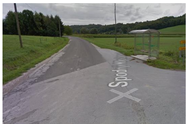
Slika 70: Vstopna postaja Sp. Ključarovci (Vir: https://earth.google.com/web/ )
